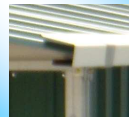
Particolare della gronda.
